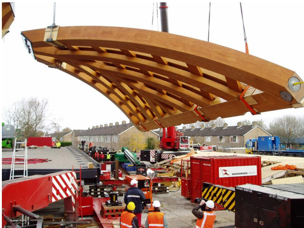
Il nuovo ponte è composto da un fondo stradale in acciaio e due arcate verticali in legno della lunghezza di 32 metri e un'altezza di 16 metri. Le arcate sono fissate mediante attacchi e stanghe tiranti. Simili ponti di legno di tali dimensioni e percorribili da qualunque tipo di veicolo non sono mai stati realizzati prima al mondo.
