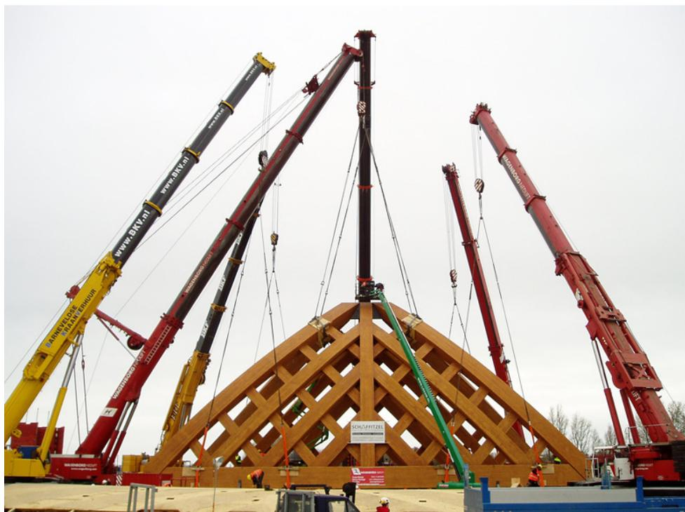
Dopo l'assemblaggio il ponte è stato sollevato alla giusta altezza per il posizionamento. Ciò è stato realizzato mediante l'impiego del sistema idraulico computerizzato Synchronous Lift System di Enerpac
