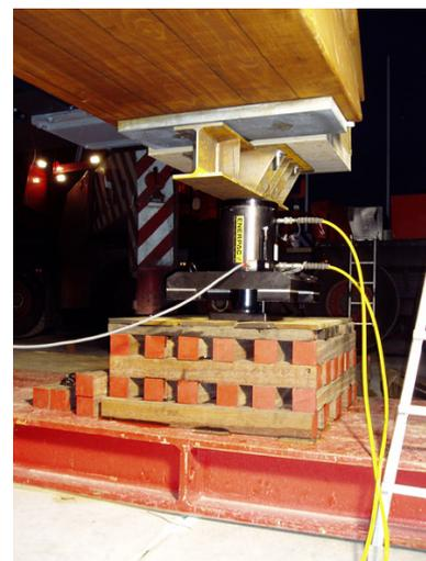
Su quattro sistemi di sollevamento a stadi Enerpac (tipo BALS2506E100) ognuno con una portata fino a 250 tonnellate sono state disposte a strati in ordine incrociato le travi in legno duro. Il ponte è stato sollevato di circa 50 centimetri all'ora e alla fine l'intera costruzione poggiava su quattro 'torri di travi' ognuna alta circa quattro metri.
