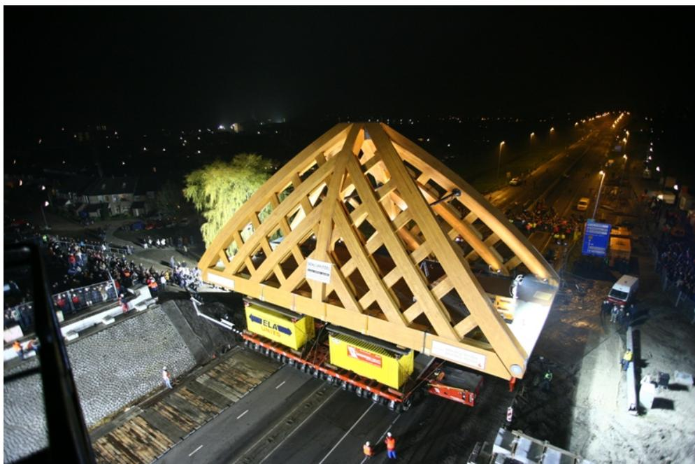
Quello che rende il ponte Akkerwinde così unico è la costruzione in legno che sorregge il fondo stradale in acciaio. Inoltre i veicoli che possono attraversarlo sono della classe più elevata (60 tonnellate)
